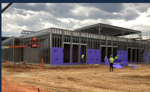
Exterior metal stud framing (Area C)
