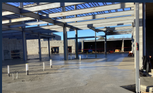
Concrete slab pour (Area A)
